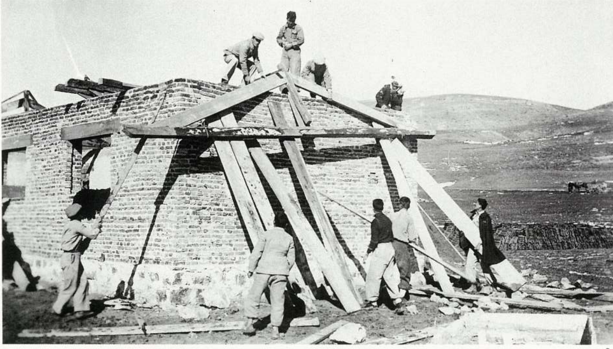
34- Sivas Yıldızeli Köy Enstitüsü inşaatı
