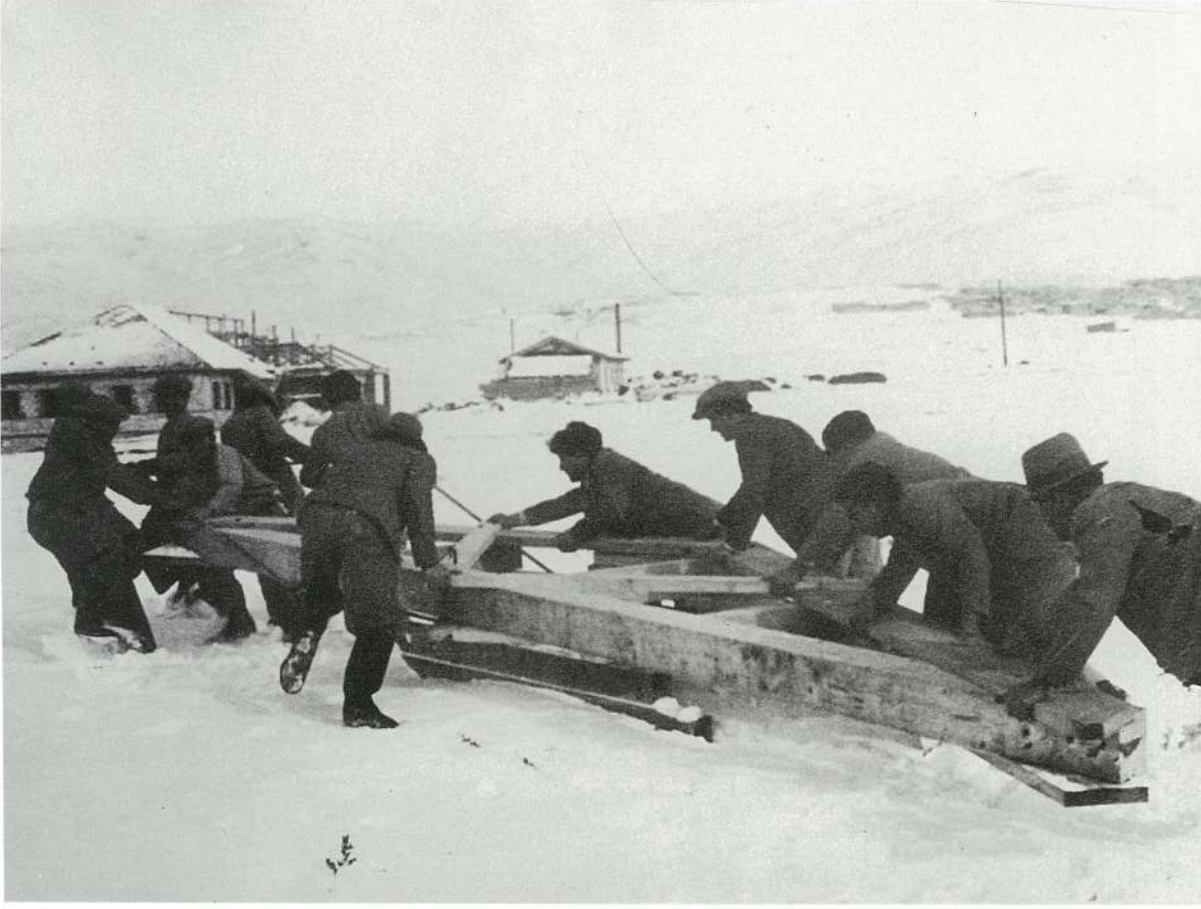
27- Çetin kış şartlarında Hasanoğlan Köy Enstitüsü'nde çatı inşaatı devam ediyor.
