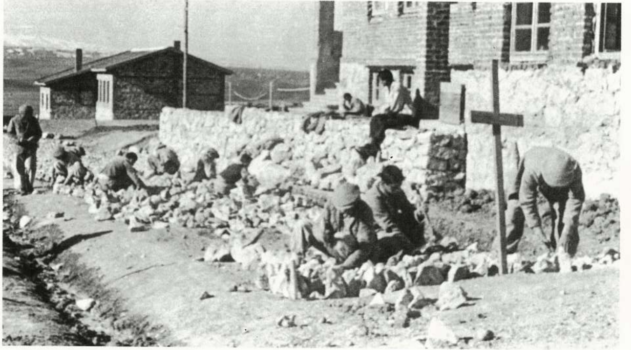
27,28,29-Hasanođlan Köy Enstitüsü'nde öđrencilerin yol yapım çalışmaları
