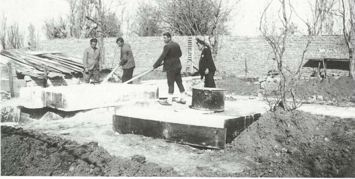
21,22,23- Kireç eri- tilmesi ve harç yapılması
