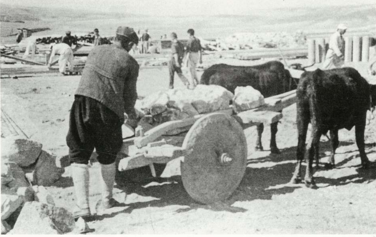
12,13,14,15-Temel taşları taşınıyor. Yapıcı köy çocuğunun elleriyle duvarlar yükseliyor.
