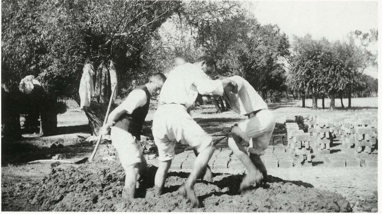
13,14,15- Kastamonu Gölköy Köy Enstitüsü binalarının yapımı için tuğla üretilmesi
