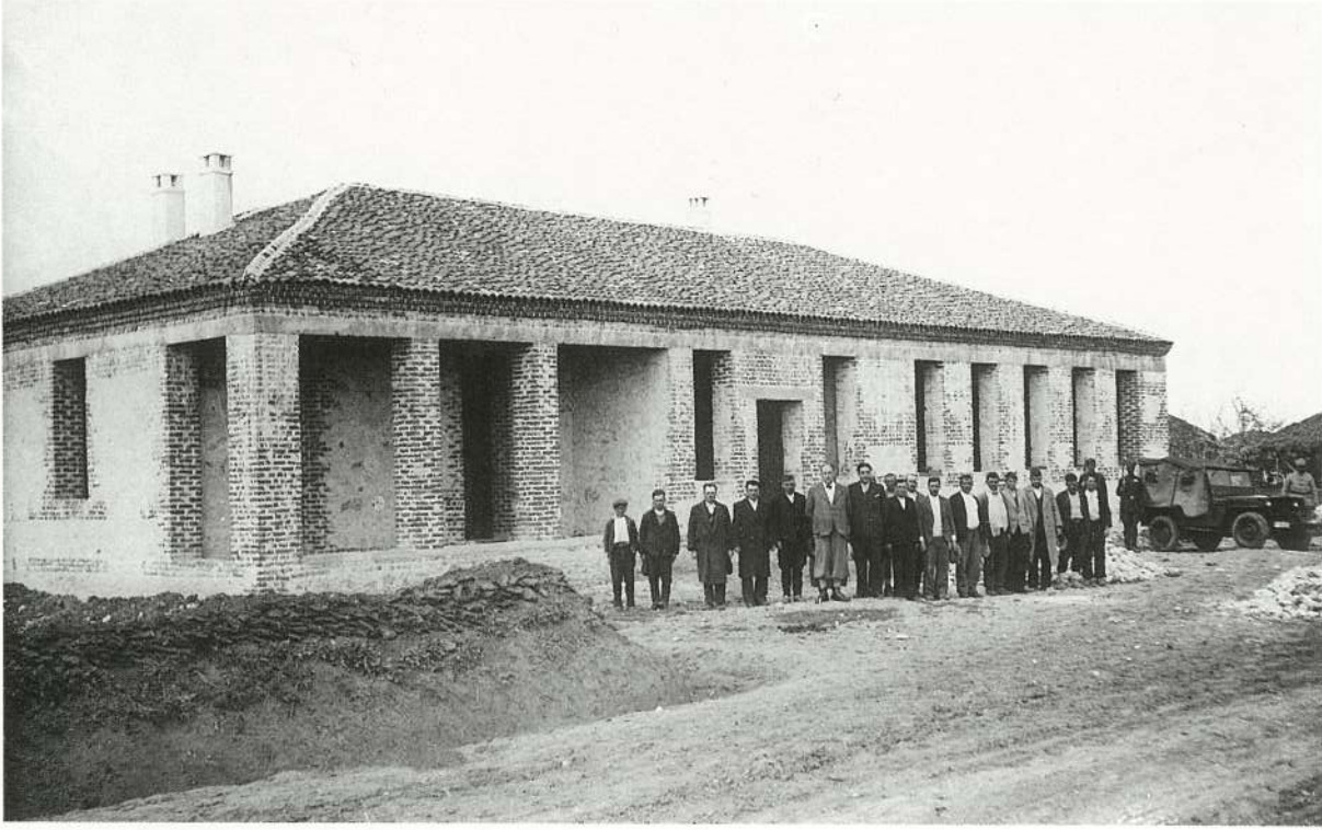
8- Çorlu İğneler Köyü İlkokulu inşaatı (1944)
