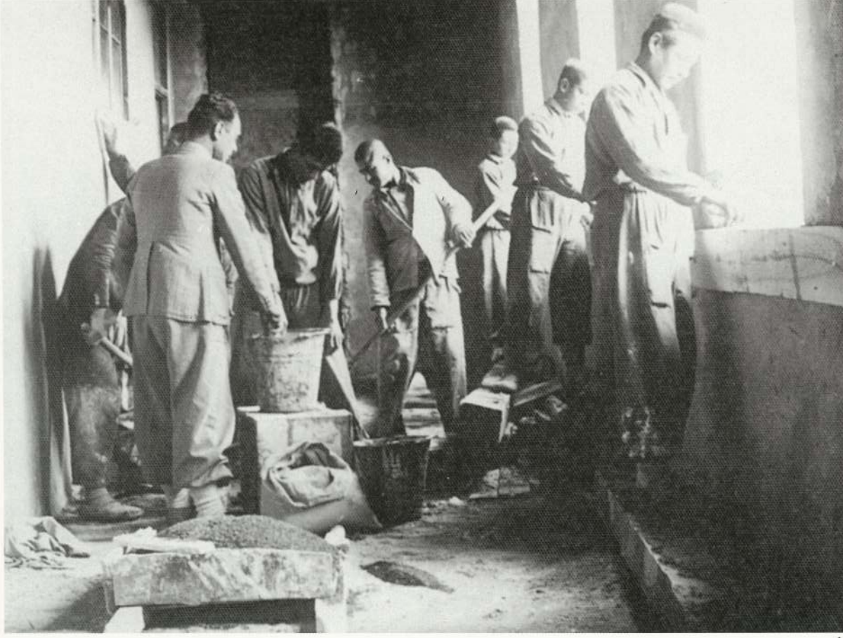
41- İvriz Köy Enstitüsü inşaatında Düziçi Köy Enstitüsü öğrencileri. Yeni kurulan Enstitülerde daha önce açılan Enstitülerin öğrencileri binaları yapıyorlardı. 42- Eskişehir Çifteler Köy Enstitüsü'nde bina yapımı
