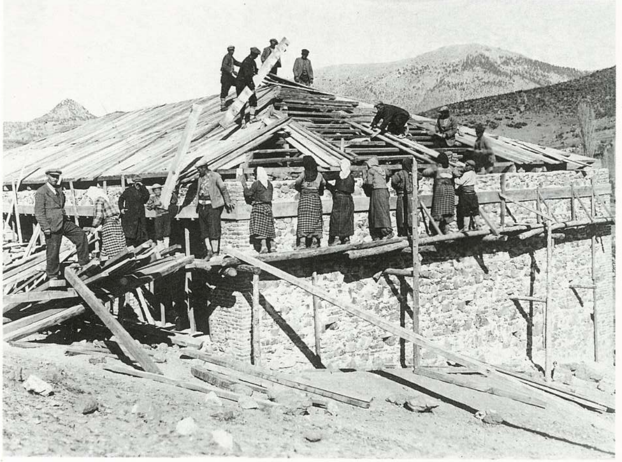
5,6,7- Köy İlkokulu inşaatlarından görün- tüler (5. Eğirdir Koçular Köyü)
